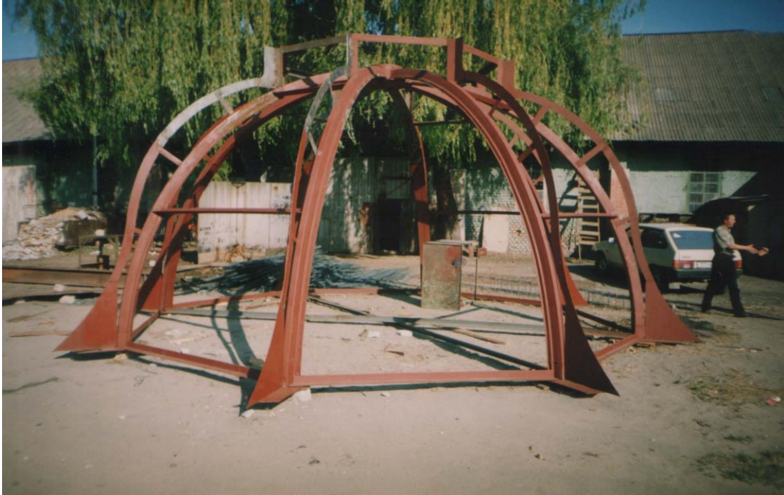
Изготовление каркаса купола церкви из профиля СВП
